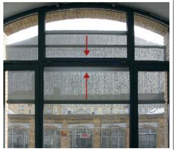
Außenrollos für den Denkmalschutz (Innenansicht)
