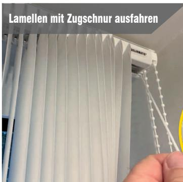
Lamellen mit Zugschnur ausfahren
