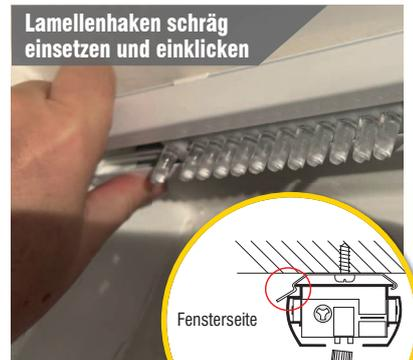
Lamellenhaken schräg einsetzen und einklicken
